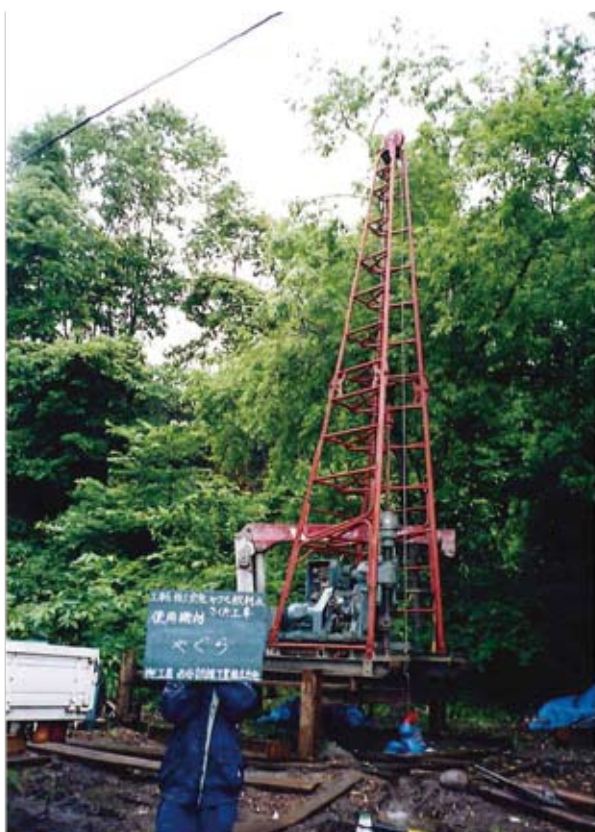
北海道八雲町地内の地下約 80m を掘り、 水を汲み上げるための工事を行いました。 (平成 11 年 7 月)
